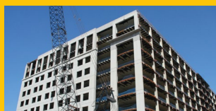
REPARACIÓN DE CONCRETO
