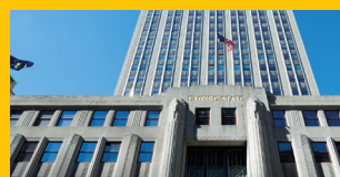
REPARACIÓN Y PROTECCIÓN
