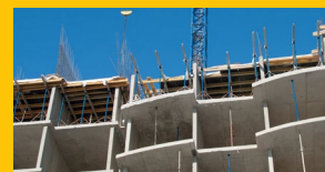
FUNDICIÓN IN-SITU Y PREFABRICADOS DE CONCRETO
