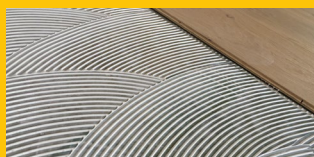
INSTALACIÓN DE PISOS
