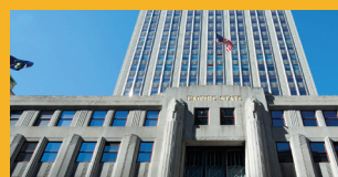
REPARACIÓN Y PROTECCIÓN
