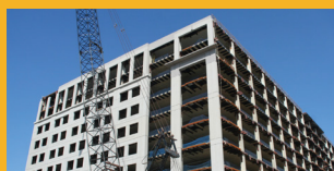
REPARACIÓN DE CONCRETO
