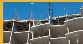
FUNDICIÓN IN-SITU Y PREFABRICADOS DE CONCRETO
