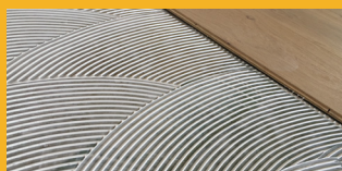
INSTALACIÓN DE PISOS
