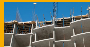
FUNDICIÓN IN-SITU Y PREFABRICADOS DE CONCRETO
