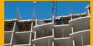
FUNDICIÓN IN-SITU Y PREFABRICADOS DE CONCRETO
