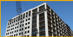
REPARACIÓN DE CONCRETO
