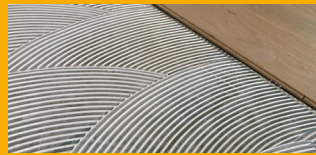
INSTALACIÓN DE PISOS
