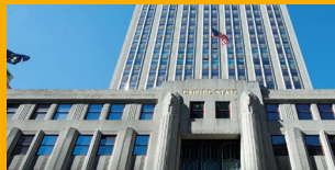
REPARACIÓN Y PROTECCIÓN
