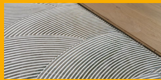
INSTALACIÓN DE PISOS
