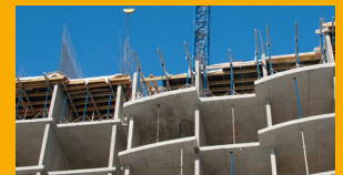
FUNDICIÓN IN-SITU Y PREFABRICADOS DE CONCRETO
