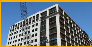
REPARACIÓN DE CONCRETO
