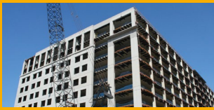
REPARACIÓN DE CONCRETO
