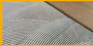
INSTALACIÓN DE PISOS
