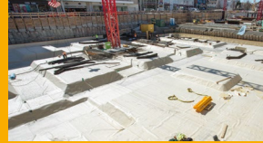
IMPERMEABILIZACIÓN SUBTERRÁNEA
