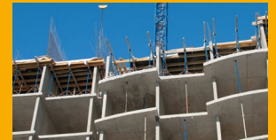
FUNDICIÓN IN-SITU Y PREFABRICADOS DE CONCRETO
