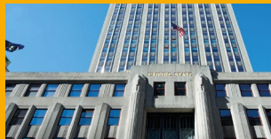
REPARACIÓN Y PROTECCIÓN
