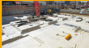
IMPERMEABILIZACIÓN SUBTERRÁNEA
