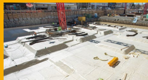
IMPERMEABILIZACIÓN SUBTERRÁNEA
