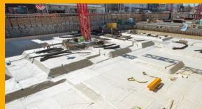
IMPERMEABILIZACIÓN SUBTERRÁNEA
