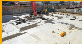
IMPERMEABILIZACIÓN SUBTERRÁNEA
