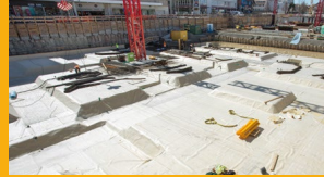
IMPERMEABILIZAÇÃO DE SUBSOLOS
