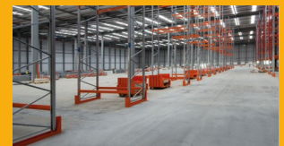
PISOS DE CONCRETO
