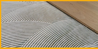
INSTALAÇÃO DE REVESTIMENTOS PISOS
