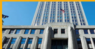
REPARO E PROTEÇÃO
