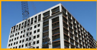
REPARO DE CONCRETO
