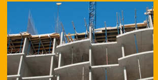
FUNDICIÓN IN-SITU Y PREFABRICADOS DE CONCRETO
