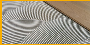
INSTALACIÓN DE PISOS
