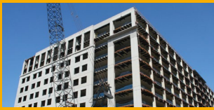
REPARACIÓN DE CONCRETO
