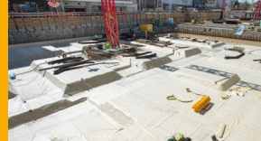
IMPERMEABILIZACIÓN SUBTERRÁNEA
