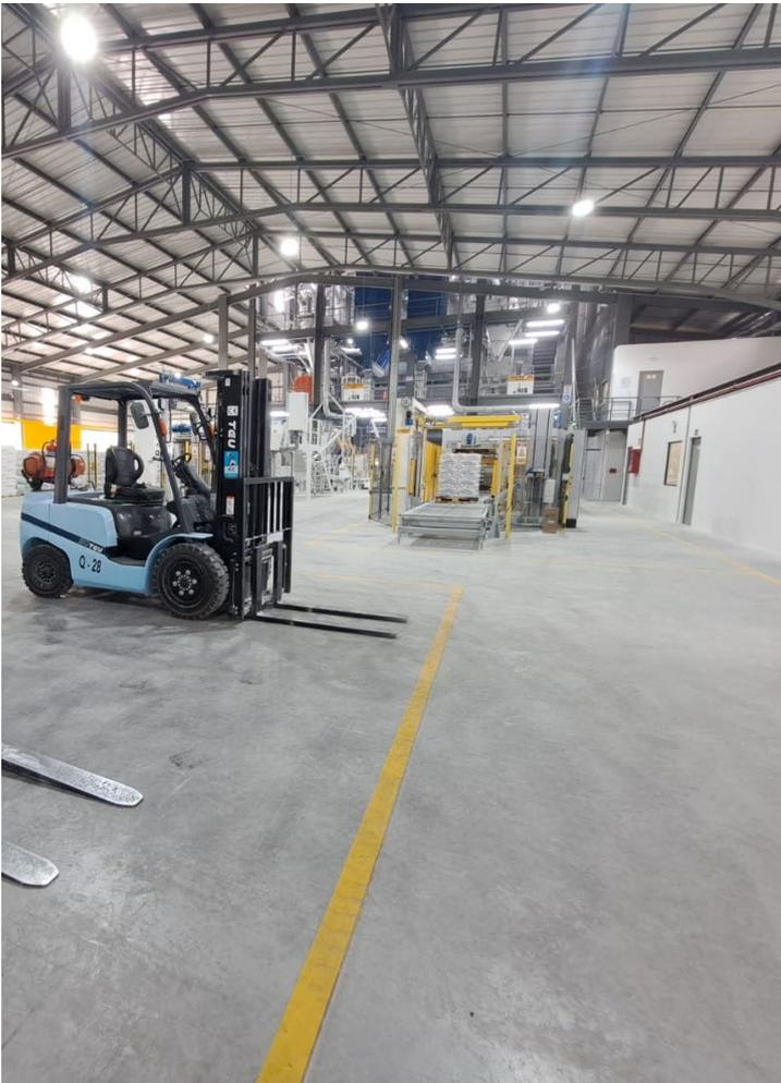
El **acabado** del piso no presenta observaciones y se ha comportado en forma eficiente post carga sin presentar zonas de fisuración o de falla estructural.
