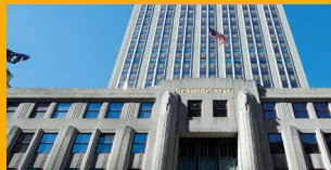
REPARACIÓN Y PROTECCIÓN
