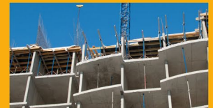
FUNDICIÓN IN-SITU Y PREFABRICADOS DE CONCRETO
