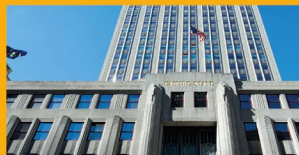
REPARACIÓN Y PROTECCIÓN
