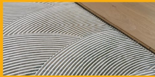
INSTALACIÓN DE PISOS
