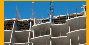
FUNDICIÓN IN-SITU Y PREFABRICADOS DE CONCRETO
