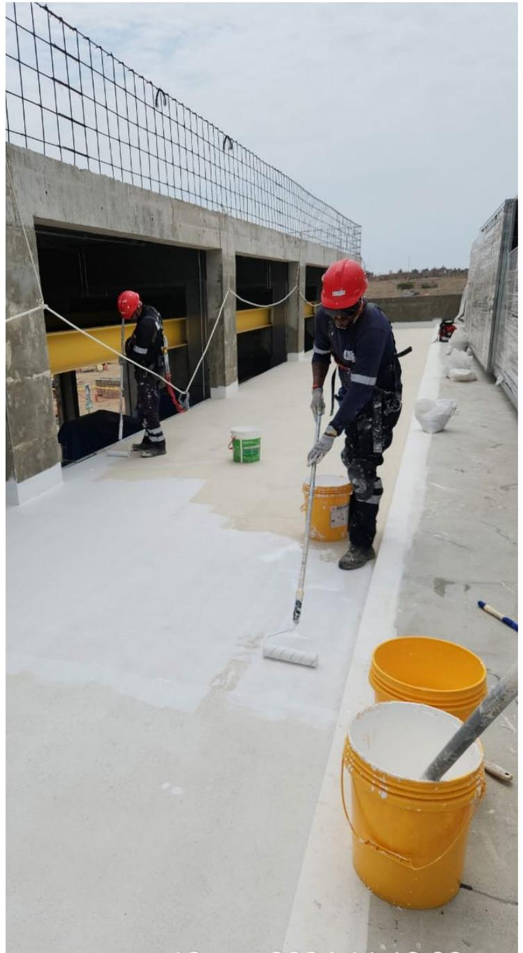
dar sucesivas capas de Sikafill® -300 Thermic hasta conseguir el espesor de película deseado. Antes de aplicar una capa, deberá estar totalmente seca la anterior. Dependiendo de los usos, y en el caso de ser necesario su empleo, se colocará sobre la primera mano aún fresca de Sikafill®- 300 Thermic aplicado sin diluir, recubriéndola con una segunda capa.
