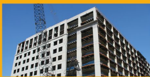
REPARACIÓN DE CONCRETO
