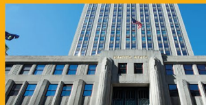
REPARACIÓN Y PROTECCIÓN
