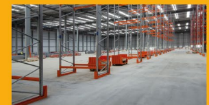
LOSAS DE CONCRETO
