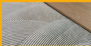
INSTALACIÓN DE PISOS
