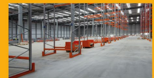
LOSAS DE CONCRETO
