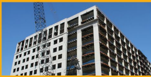
REPARACIÓN DE CONCRETO
