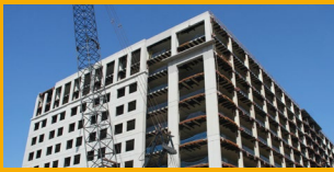
REPARACIÓN DE CONCRETO
