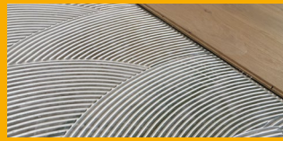
INSTALACIÓN DE PISOS
