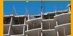
FUNDICIÓN IN-SITU Y PREFABRICADOS DE CONCRETO
