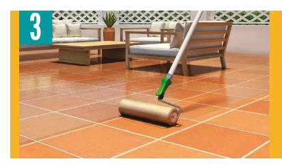
Aplicar dos capas de **SikaFill® Tapagoteras** en toda la superficie, en las uniones entre piso y muro aplicar el producto hasta una altura de 15 cm sobre el muro.
