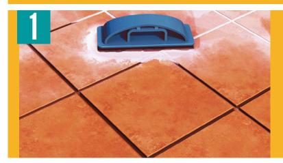
Repara las juntas existentes con **Binda® Fraguador**.
